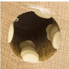
6. Die Tischfüße werden mit dem mitgelieferten PU-Kleber eingeklebt. Es sollten hierfür 4 Kleberraupen mit ca. 8 mm Durchmesser aufgetragen werden. Die Tischfüße mit einer leichten Links-Rechts-Drehbewegung aufsetzen, sodass sich der Kleber in der Bohrung gleichmäßig verteilt. Siehe Abbildung
