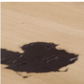
Achten Sie bitte darauf, dass die auszufüllende Stelle sauber und staubfrei ist. Am besten mit einem Stemmeisen oder dergleichen auskratzen, sodass eine frische Bruchstelle entsteht, dadurch ist eine optimale Haftung des Materials gewährleistet.
